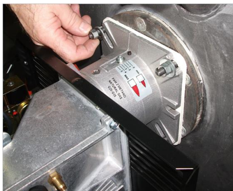
7) Зафиксировать горелки на котел;
