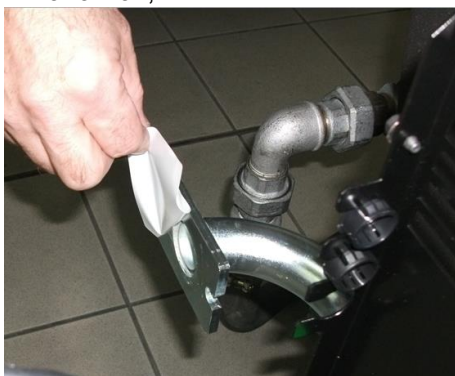
7) Снять заглушку из Труба ГАЗОВОЙ ramпы;
