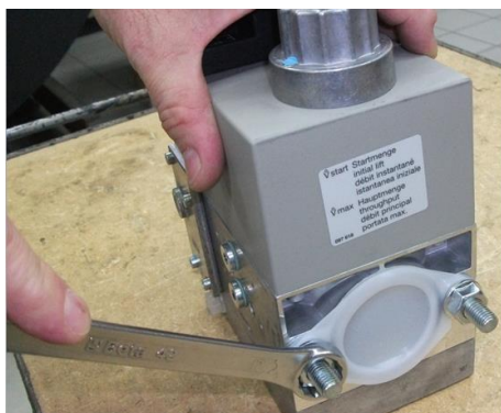
7) Снять заглушку из электроклапан;
