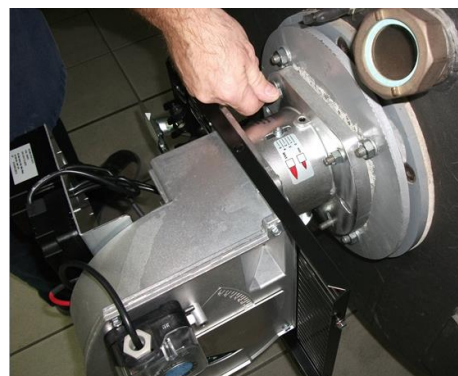
6) Зафиксировать горелки на котел;
