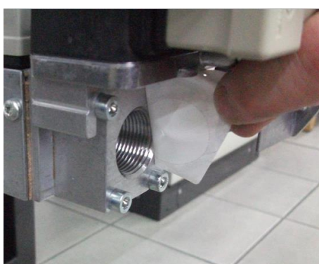
8) Снять заглушку из Труба ГАЗОВОЙ ramпы;
