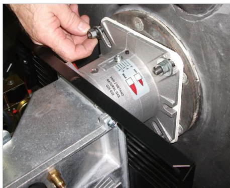
7) Зафиксировать горелки на котел;
