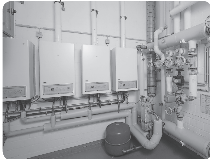
Нагревательные котлы, каскадное подключение
