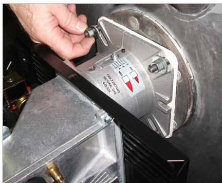
7) Зафиксировать горелки на котел;
