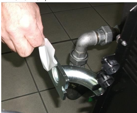
7) Снять заглушку из Труба ГАЗОВОЙ ramпы;
