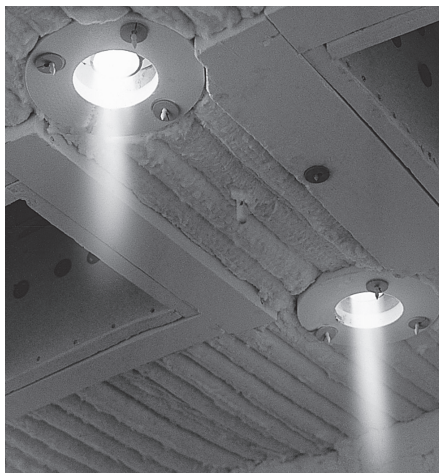
Термическая печь с горелками BIC
